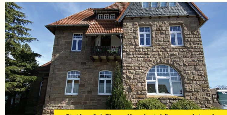
Station 3 | Ehemalige Amtsbürgermeisterei
